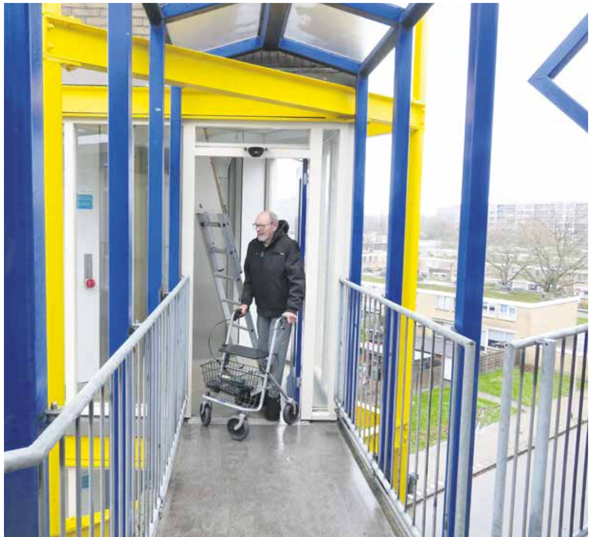
Bewoner en hartpatiënt Huizinga voor de defecte lift
